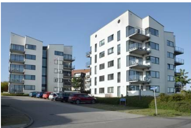
Illustration 19: De høje punkthuse skal udformes skulpturelt, som en sammenstilling af murede flader, vertikale glasbånd i samspil med integrerede altaner, enkeltvinduer og vinduesbånd, der gerne må løbe omkring bygningskroppens hjørner.
